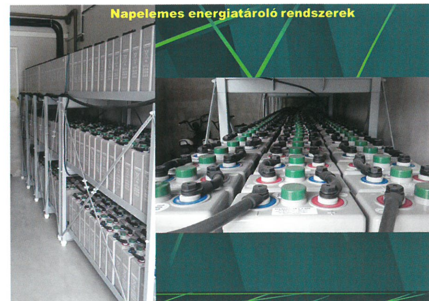
5. ábra: 30kVA-es UPS akkumulátortelepe
