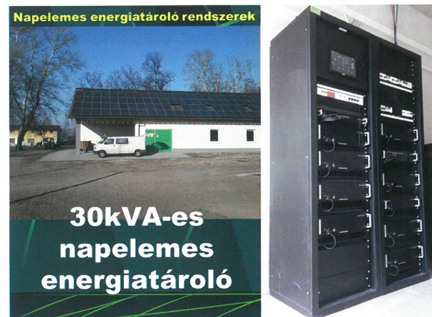
4. ábra: 30kVA-es napelemes szünetmentes áramellátó rendszer
