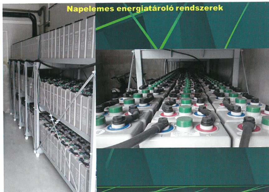
5. ábra: 30kVA-es UPS akkumulátortelepe
